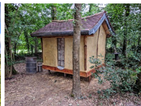
Construction de poulailler pour petit élevage de pondeuses
