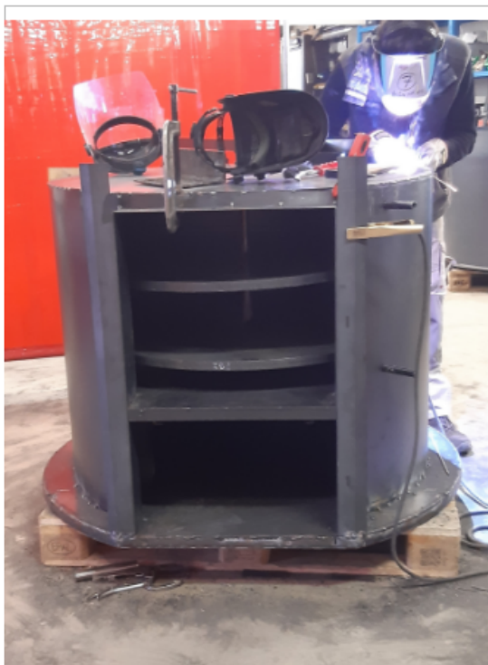
(6) Soudure en cours... Le four prend forme : en haut, la chambre de cuisson avec les 2 soles, et en bas, le foyer.
